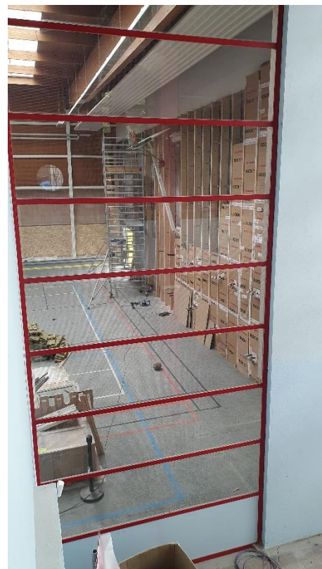
Figure 9. Isolation thermique intérieur du gymnase
