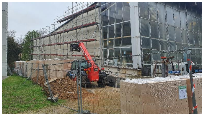
Figure 1. Isolation extérieure en laine de bois
