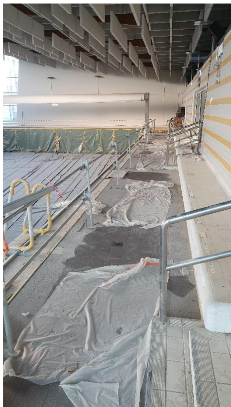
Figure 19. Protection bassin inox et carrelage des plages
