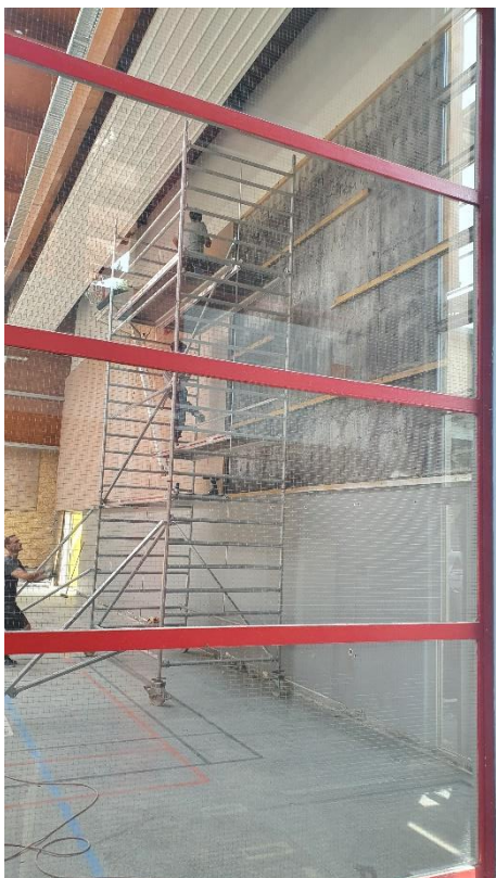
Figure 7. Isolation thermique intérieur du gymnase
