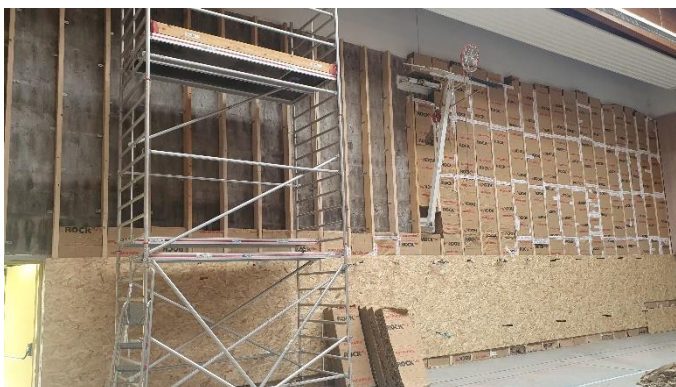
Figure 16. Isolation thermique intérieure du gymnase
