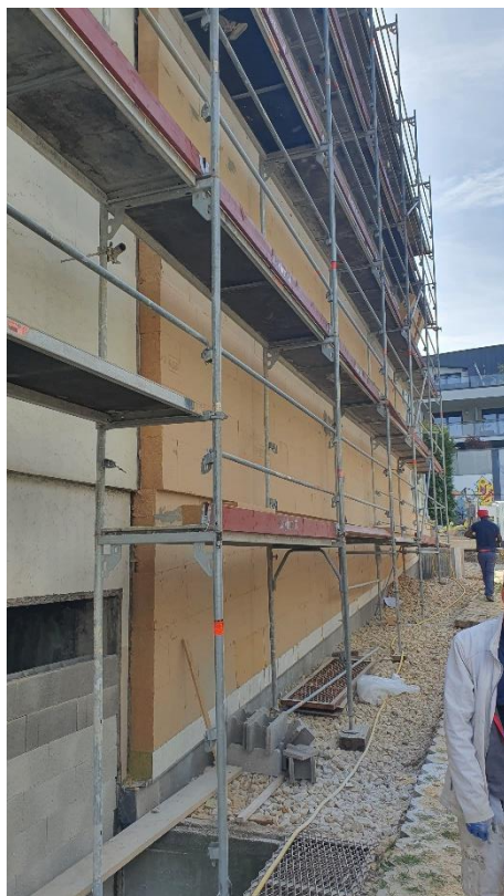
Figure 11. Isolation extérieure en laine de bois
