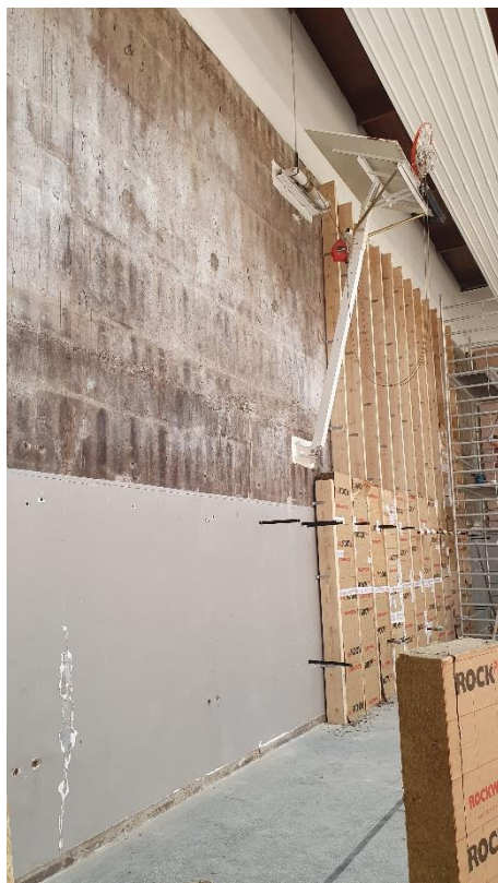
Figure 8. Isolation thermique intérieur du gymnase
