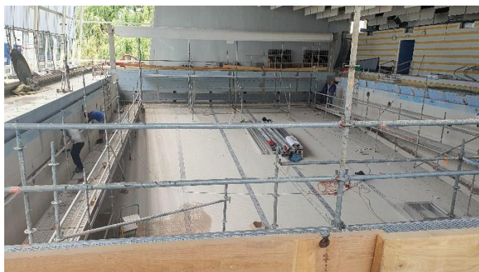
Figure 13. Réalisation du bassin Inox
