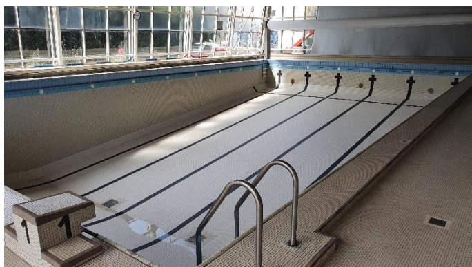
Figure 3. Bassin vide avant travaux
