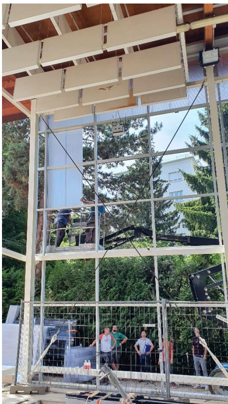
Figure 10. Pose structure du nouveau mur rideau
