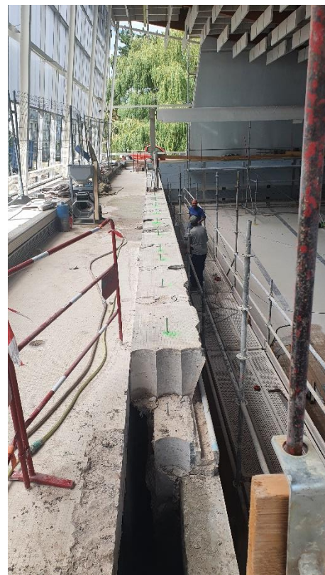
Figure 12. Réalisation du bassin Inox
