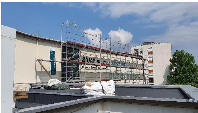
Figure 2. Réfection étanchéité et isolation des toitures des locaux annexes
