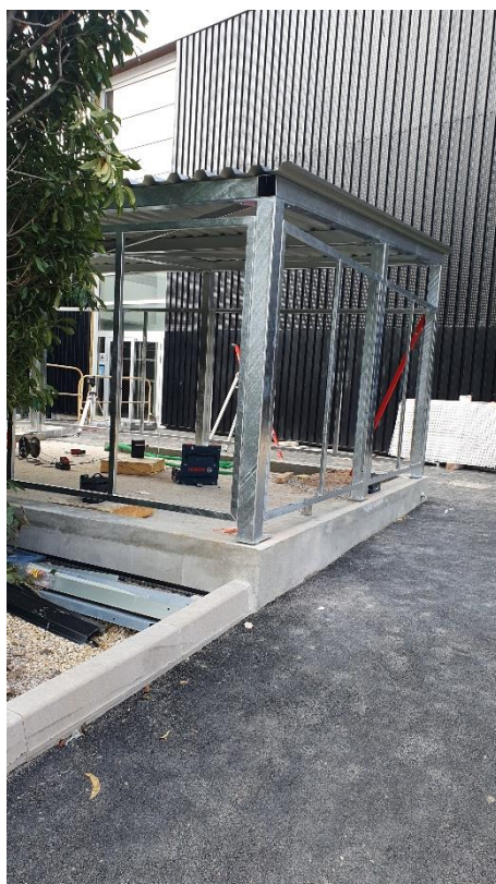
Figure 23. Structure nouvel abri vélos
