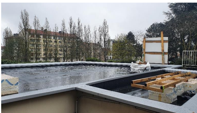
Figure 18. Réfection étanchéité et isolation des toitures des locaux annexes
